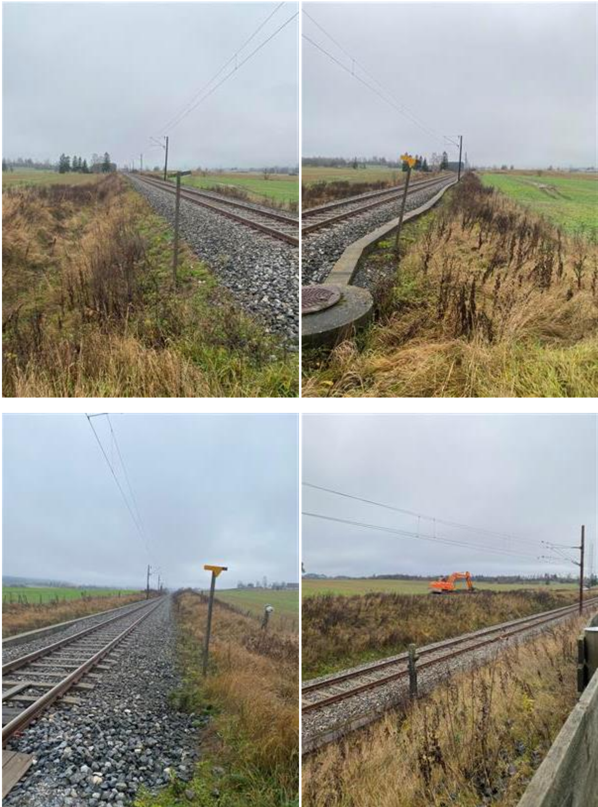
Figur 2-11. Foto tatt ved planovergang Løkenveien, og viser linja og dyrka mark mot nord øverst, og mot sør nederst. Foto nederst til høyre viser området hvor det er antatt høyest skjæring ned mot linja, ca. 170 m sør for planovergang.
