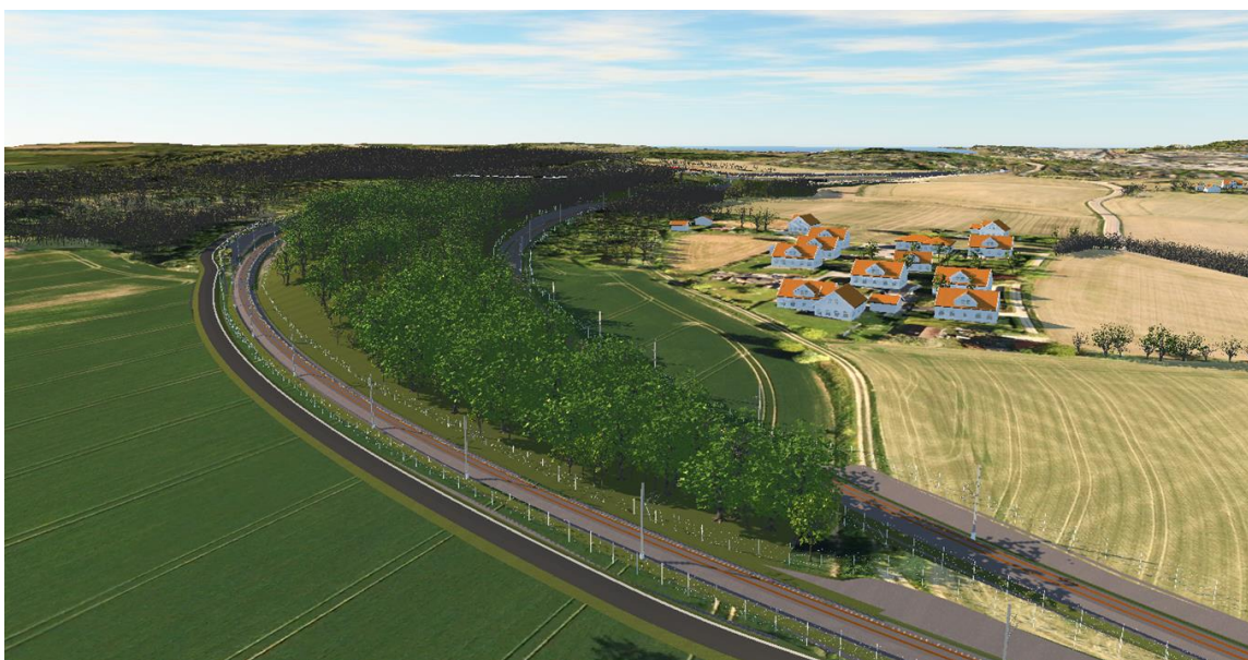
Figur 1.5 Illustrasjonsbilde av deponi mellom nord- og sørgående spor i delområde O1 sett fra sørsiden.
