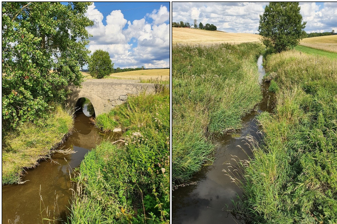
Figur 5 - Engsbekken ved kryssing med Løkenveien.
