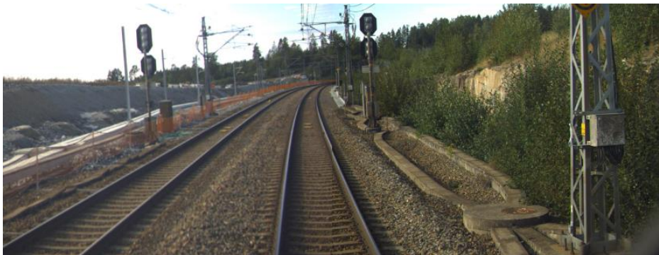
Figur 3-5: Målevognbilde, i nærheten av ny avgreining Østre linje. Km. 25,600. Kilde: Bane NOR
