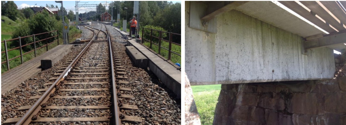
Figur 3-7: Bru for Østre linje over Kråkstadelva, nord for Kråkstad stasjon. Kilde: Bane NOR
