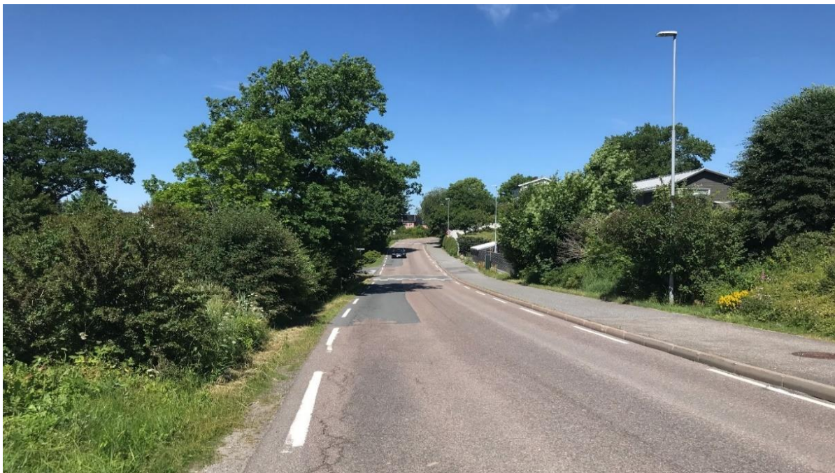
Figur 4-9 Delområde 4, Kråkstadveien over Ellingsrudåsen og Tandberggløkka. Bildet er tatt fra sør mot nord og viser typisk boligstruktur og vegetasjon. Kråkstadveien følger toppen av åsryggen mellom delområde 3 (dalformen fra Ski sentrum til Holstad) og Kjeppestadveien.
